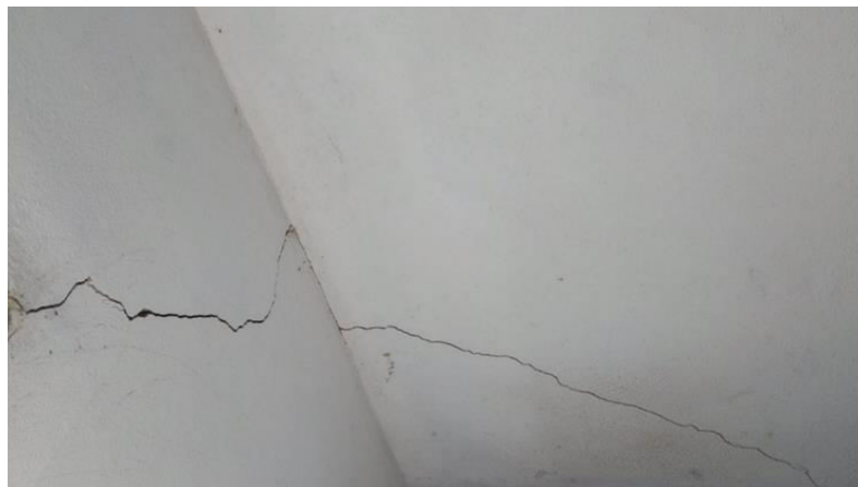
Figura 2 – Registro fotográfico referente à data de 01/04/2025.
