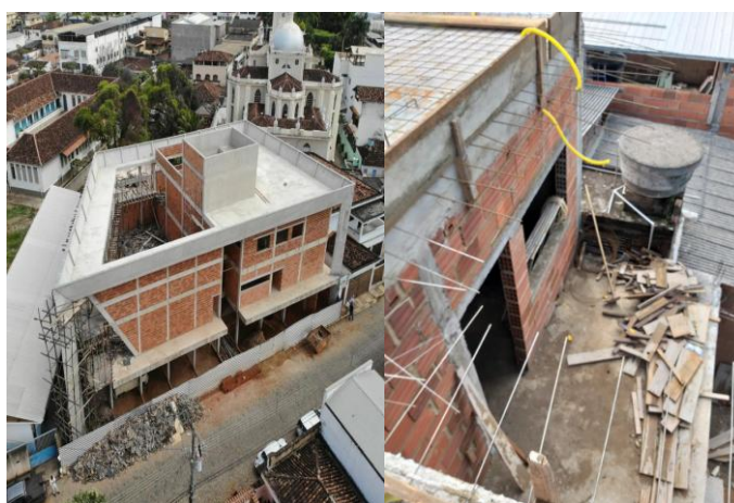
Figura 3: Vista aérea da 3ª obra analisada.
