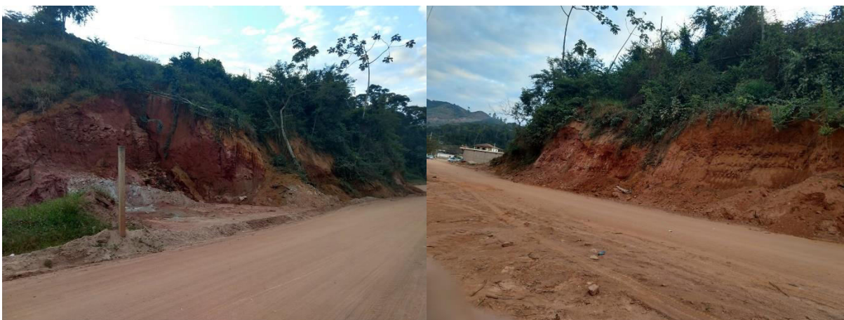
Figura 11: Talude localização da arte central da cidade, próximo ao local de encontro entre os dois Ribeirão 2 e Ribeirão Pouso Alegre. Data das imagens: 14/06/2021.
