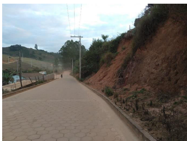
Figura13: Acesso ao distrito próximo ao ribeirão 2. Data imagem.14/06/2021
