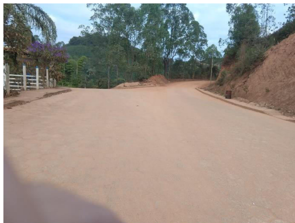
Figura 12: Acesso ao distrito pela estrada sem pavimentação que liga a sede do município de Durandé – MG. Data imagem.14/06/2021
