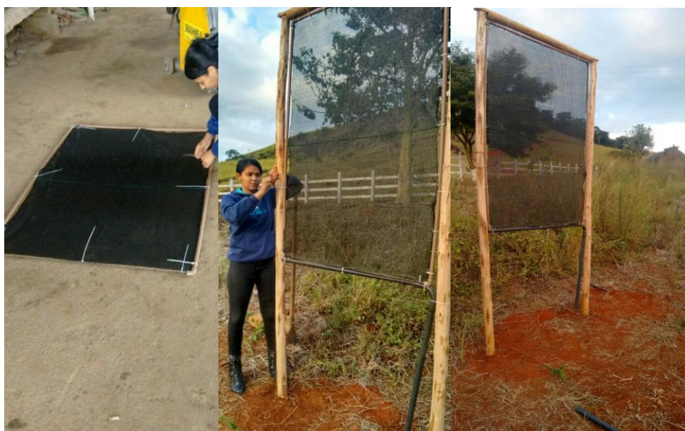
Figura 7: Execução e instalação do protótipo em Matipó MG. Fonte: Acervo particular dos autores (2018).
